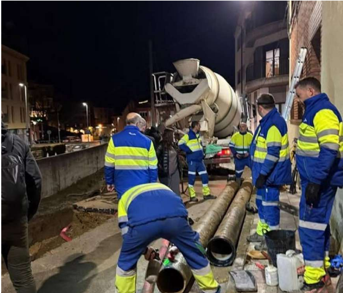
Operaris treballant ahir al vespre. / Ajuntament d'Anglès
