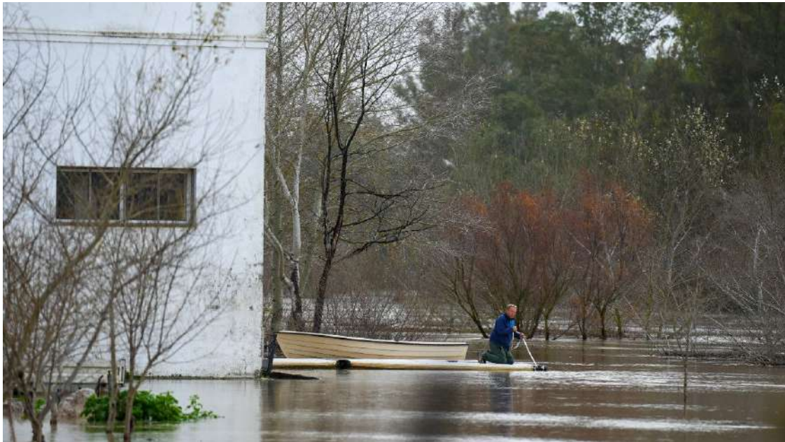
El río Guadalete, en plena crecida, a su paso por la barriada de la Corta. | Francisco J. Olmo (EP)
